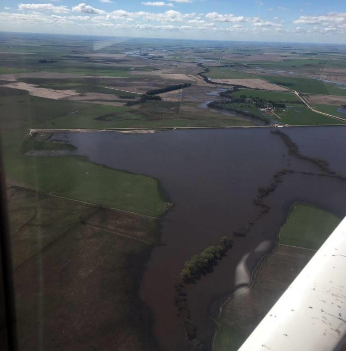
Foto 2. Vista aérea de la presa “La Isidora” del 14/09/17. Gentileza: José Lier.
